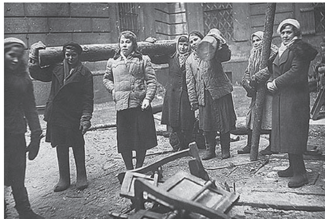
Сотрудницы ГПБ на ремонтно-восстановительных работах. 1942 г.
